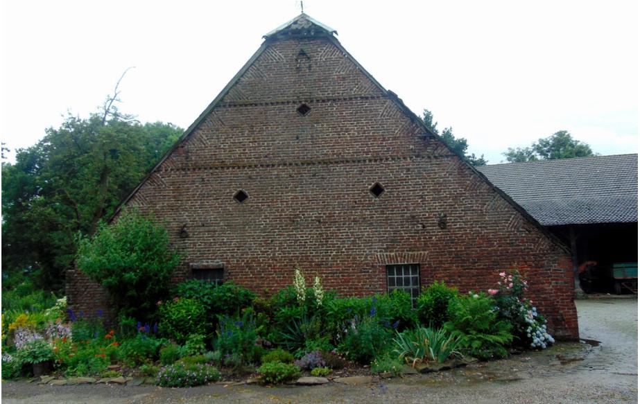
Die Außenwände sind schon in Ziegelmauerwerk ausgeführt und mittels Mauerankern mit dem inneren Fachwerkgerüst verbunden. Diese bilden die Jahreszahl 1766 als Schmuck auf der Giebelwand. Im oberen Bereich des Giebels befindet sich ein Maueranker mit dem Buchstaben A , daneben und unterhalb gemauerte Öffnungen als Eulenlöchern. Die historische Bausubstanz ist stark gefährdet nachdem das Dach offen ist und das Ständerwerk der Witterung ausgesetzt ist.
