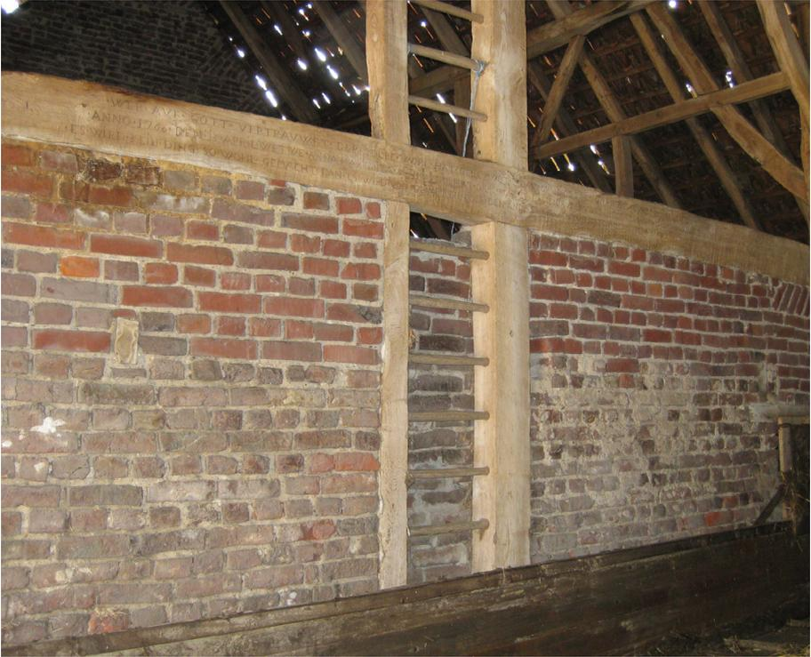
Das innere Fachwerkgerüst einer der Scheunen des Schmabershofes mit beeindruckendem Ständerwerk und quer durch die Tenne verlaufendem, beschriftetem Bundbalken.
