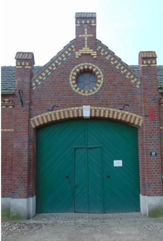
*Betonung der Giebelzier durch glasierte Backsteine (Ensen Ziegelheide)*
